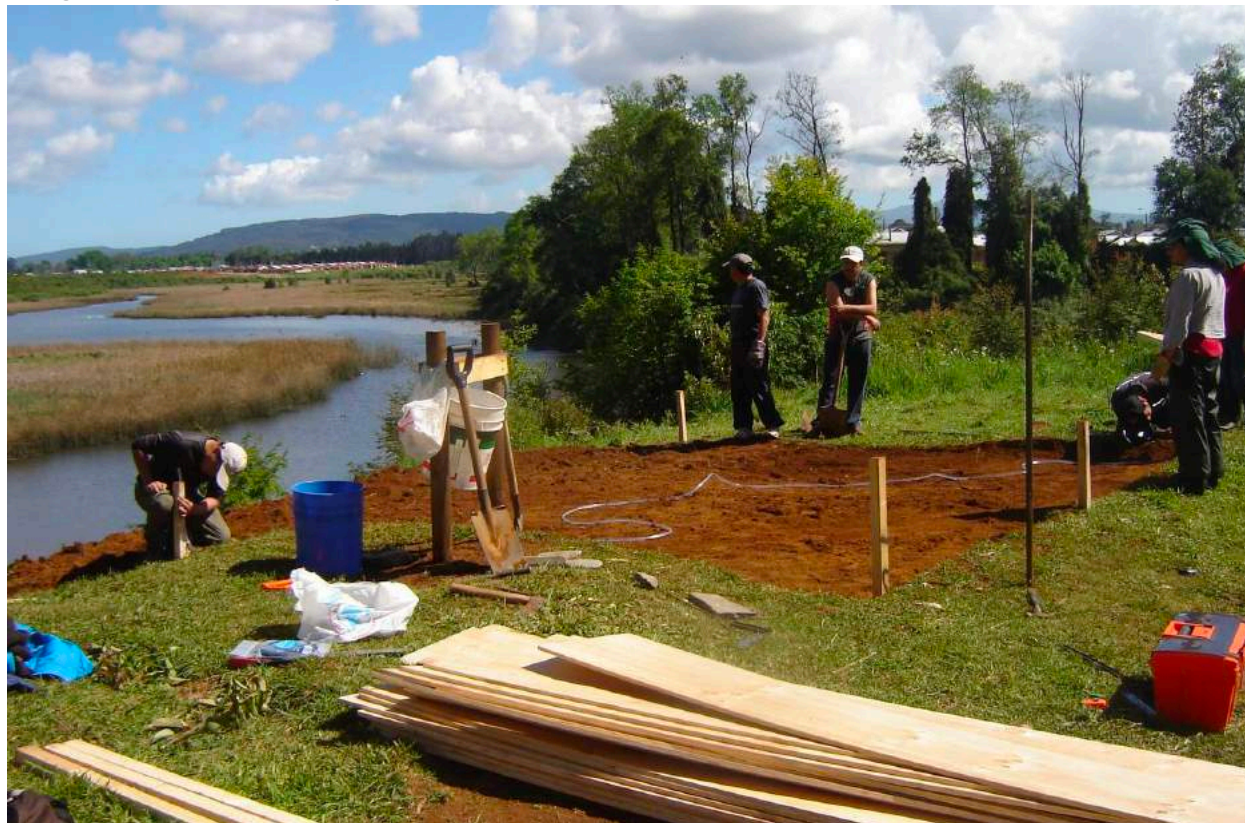
Imagen 11: Humedal Angachilla- Construcción de Miradores
